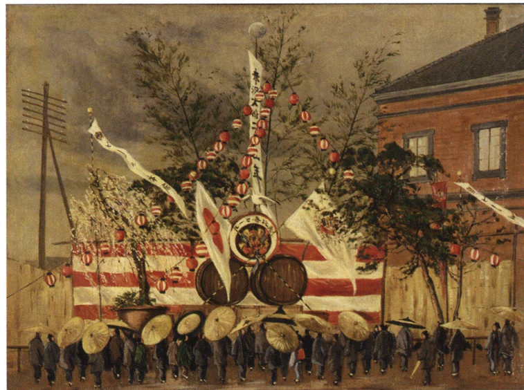
第 11 図 日本橋区日本橋橋南
