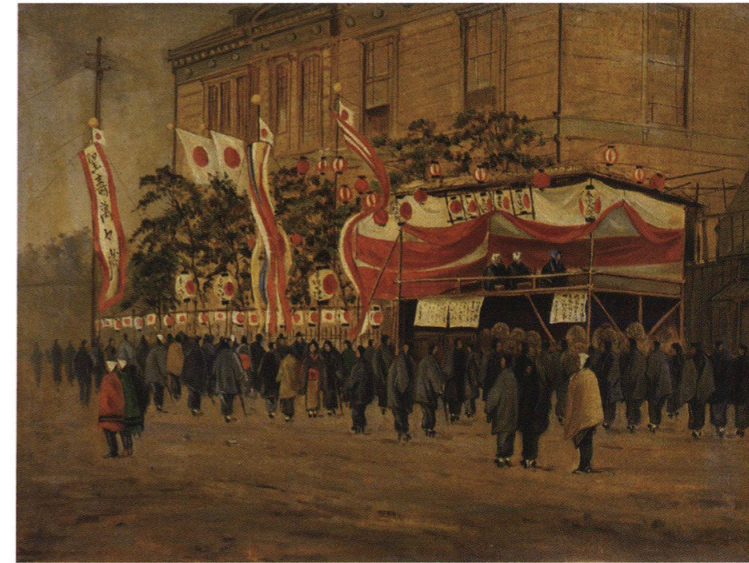
第15図 芝区新シ橋橋南
