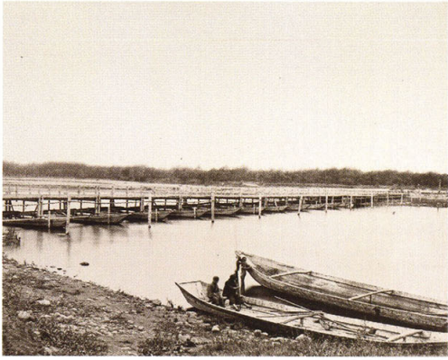
8-15 下野国上阿久津東鬼怒川橋 (栃木県)
