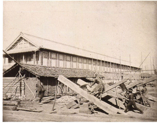
49-3 富岡製糸場の図六 (東置繭所)
