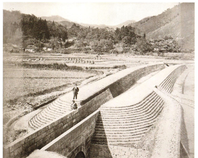
30-5 同第十二図 夏出疏水橋
