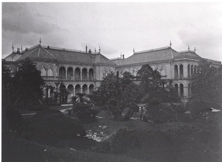
参考⑥ 霞ヶ関離宮(明治17年竣工)の外観。
