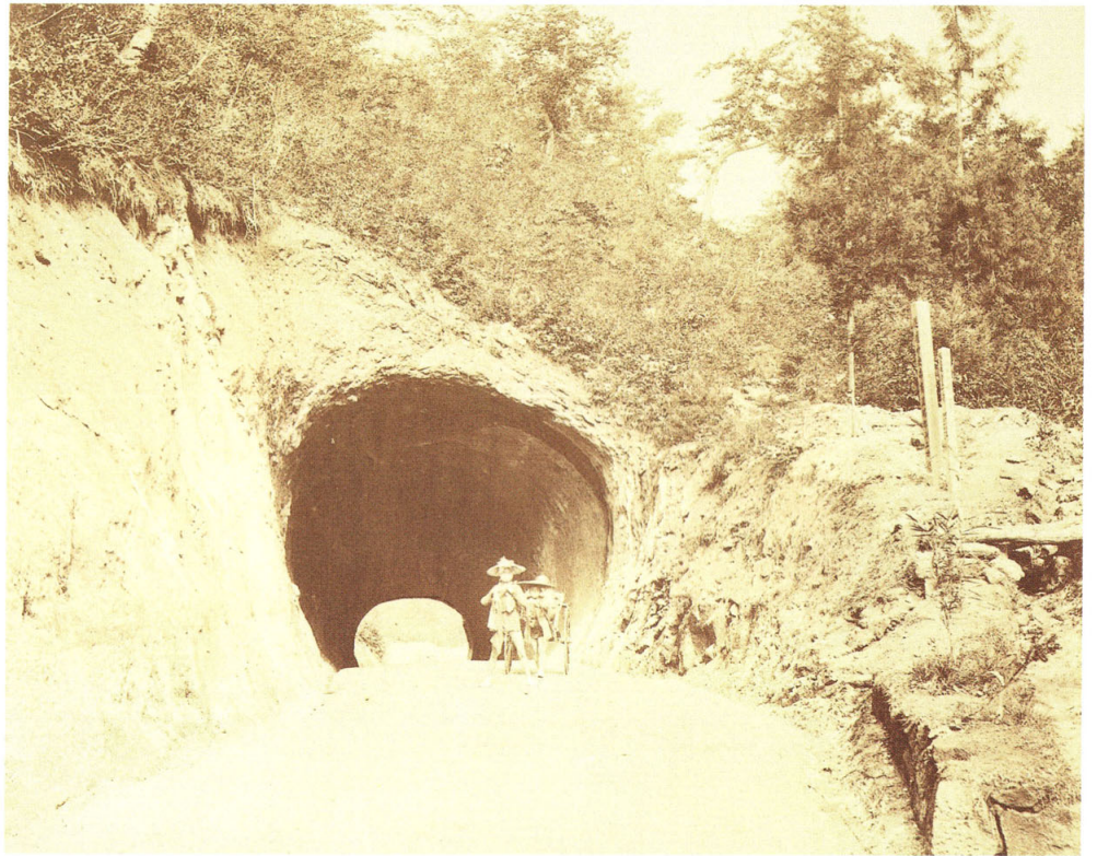
25 撮影者不詳 羽前国南置賜郡山上村刈安隧道 明治14年(1881)頃 鶏卵紙 19.3×24.0 三の丸尚蔵館
