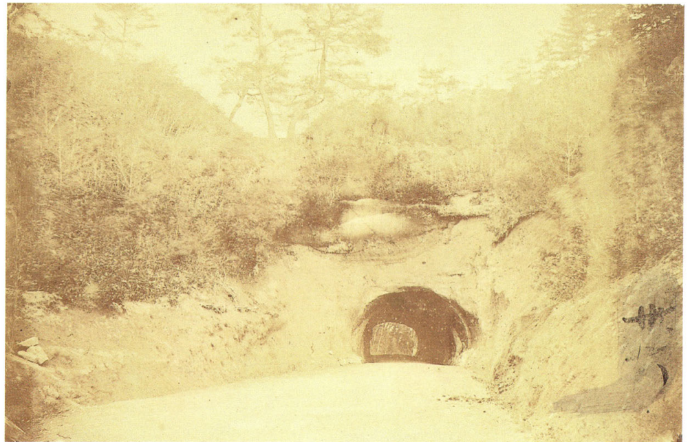
26 撮影者不詳 南置賜郡栗子新道線内刈安隧道西口 明治10年代 鶏卵紙 24.0×37.1 三の丸尚蔵館
