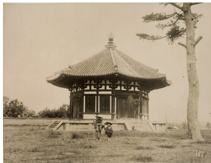
47. 大和国奈良南円堂 ※北円堂の誤り
