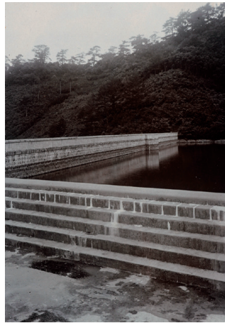
43. 長崎本河内水源地
