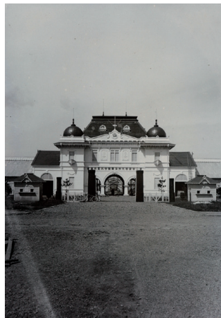
19. 第二回関西九州府県連合 水産共進会場 本館
